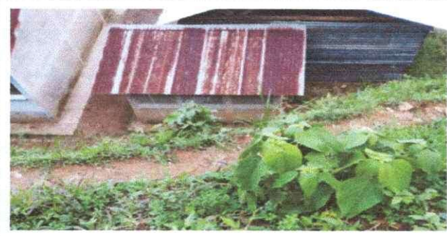
Foto 4: Sustitución de lámina por mal estado.
