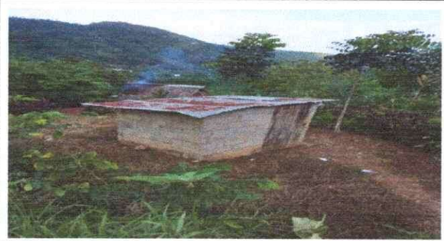
Foto 2: Sustitución de puerta de madera por metal.
